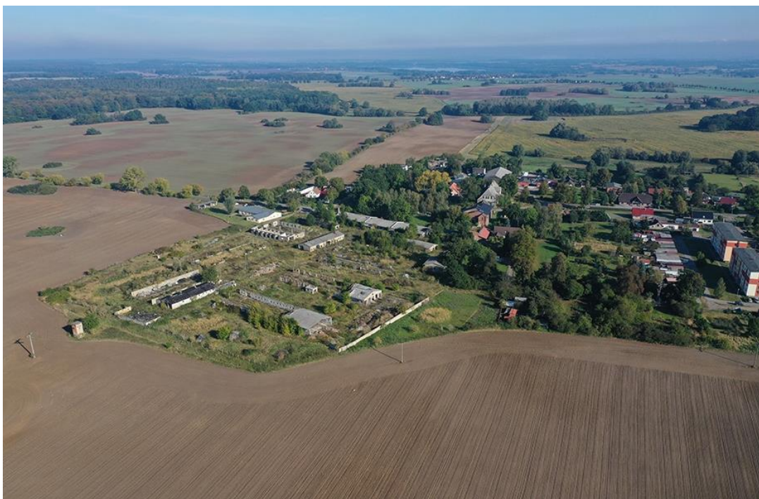
Abb. 2: Luftbild von Südosten (Quelle: https://www.lge-mv.de/aktuelles/kargow-landkreis-mecklenburgische-seenplatte-wird-neues-wohngebiet-auf-brachflaeche , 19.07.2021)
