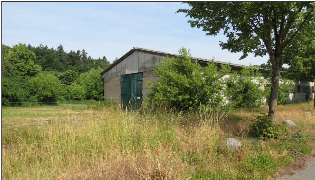
Abbildung 6: Südlicher Bereich der Teilfläche 2 mit auffälliger Lagerhalle aus Ansicht von Am Gutshof
