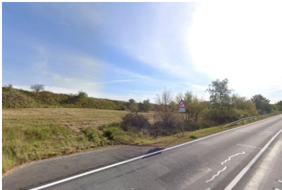
Südlicher Plangebietsrand an der L 204
