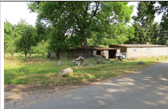
Blick nach Nordosten auf die Teilfläche 2 und das Gebäude Flst. Nr. 6/1, Flur 3
