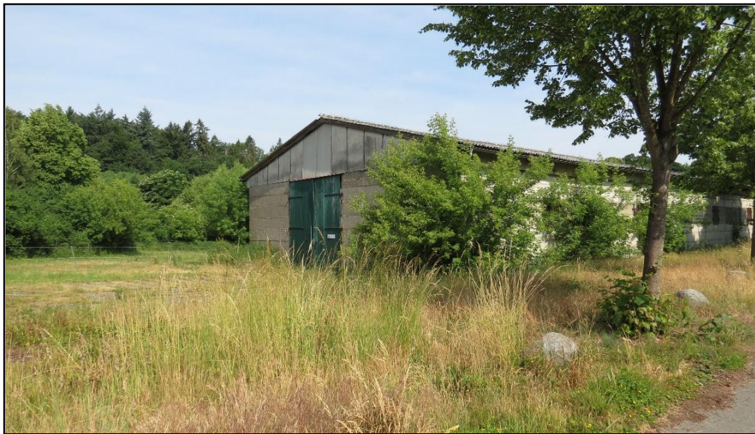
Abbildung 6: Südlicher Bereich der Teilfläche 2 mit baufälliger Lagerhalle aus Ansicht von Am Gutshof
