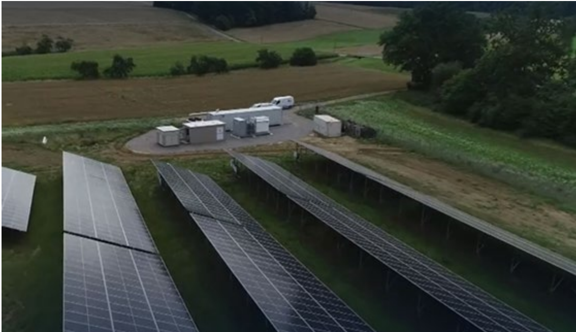
Abbildung 7: Beispiel für einen Speichercontainer angrenzend an eine PV-FFA; https://www.swr.de/swraktuell/baden-wuerttemberg/hybrid-solarpark-1930-100.html
