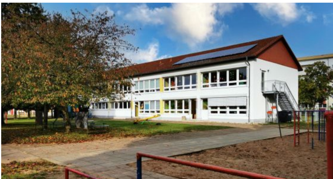
Abbildung 2: Instand zu setzende PVA auf dem KITA-Dach; solargrün
