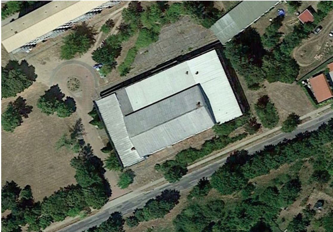
Abbildung 4: Luftbild der Sporthalle und der angrenzenden Fläche; https://www.google.de/maps/place/Hohen+Wangelin
