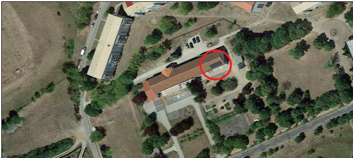
Abbildung 3: Luftbildauszug vorhandene Solaranlage auf dem Dach der Kita; https://www.google.de/maps/place/Hohen+Wangelin
