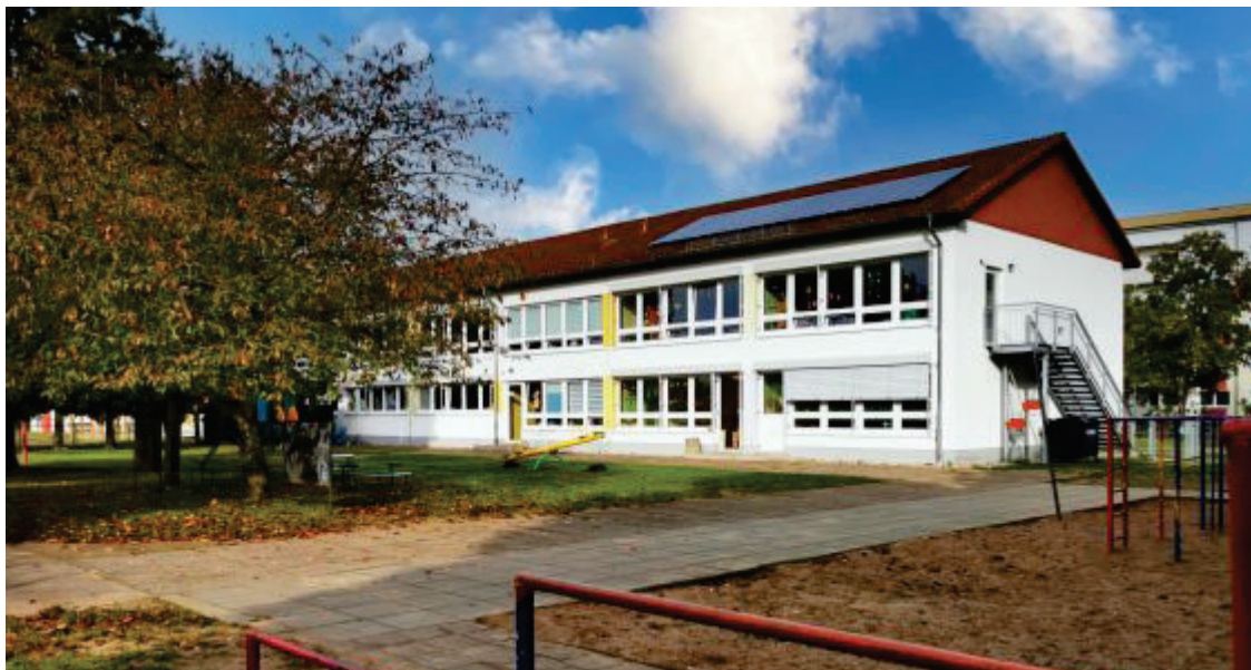
Abbildung 2: Instand zu setzende PVA auf dem KITA-Dach; solargrün
