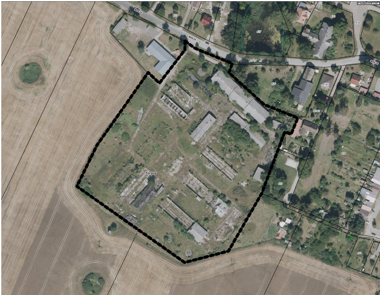
Abb. 3: Luftbild (Quelle: https://www.geoportal-mv.de/gaia/gaia.php , 15.07.2021, bearbeitet ign Ingenieure)
